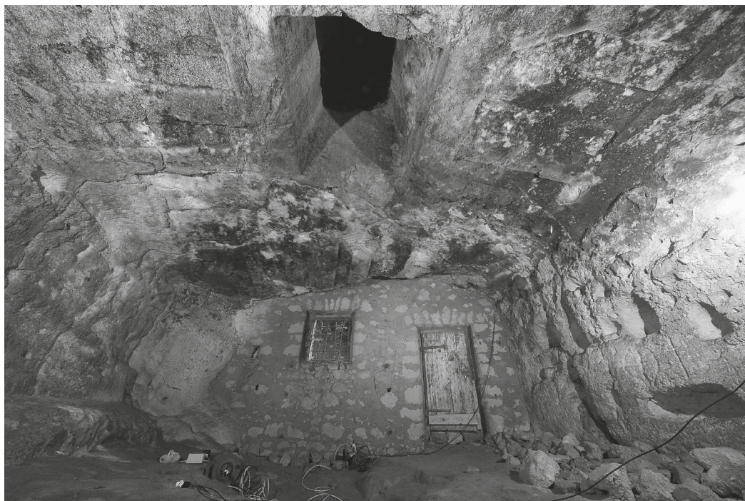
Fig. 8. Tarquinia, Tomba della Mercareccia prima del restauro del 2008.
