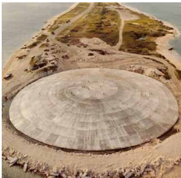
Fig. 6. la cupola in calcestruzzo, costruita sopra il cratere del test nucleare Cactus.
