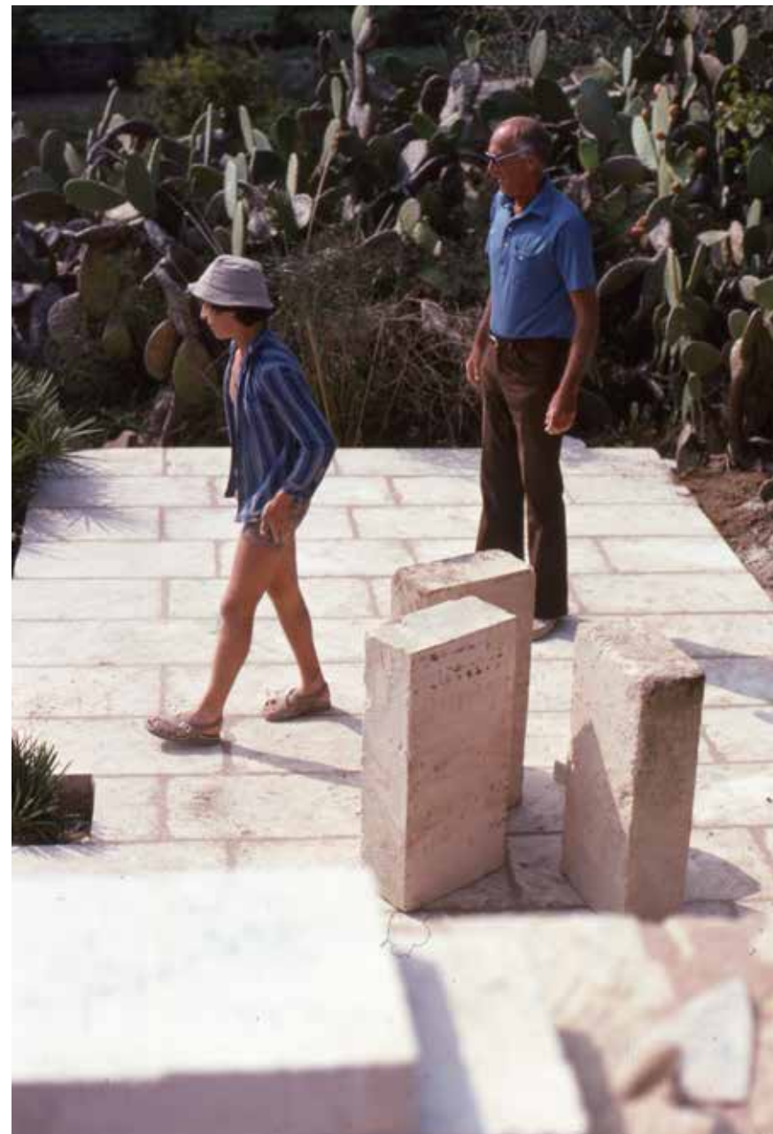
Jørn Utzon e suo figlio in cantiere durante la posa dei conci di pietra da taglio per la pavimentazione esterna. Jørn Utzon, Can Lis , 1971. © Utzon Archives / Aalborg University & Utzon Center
