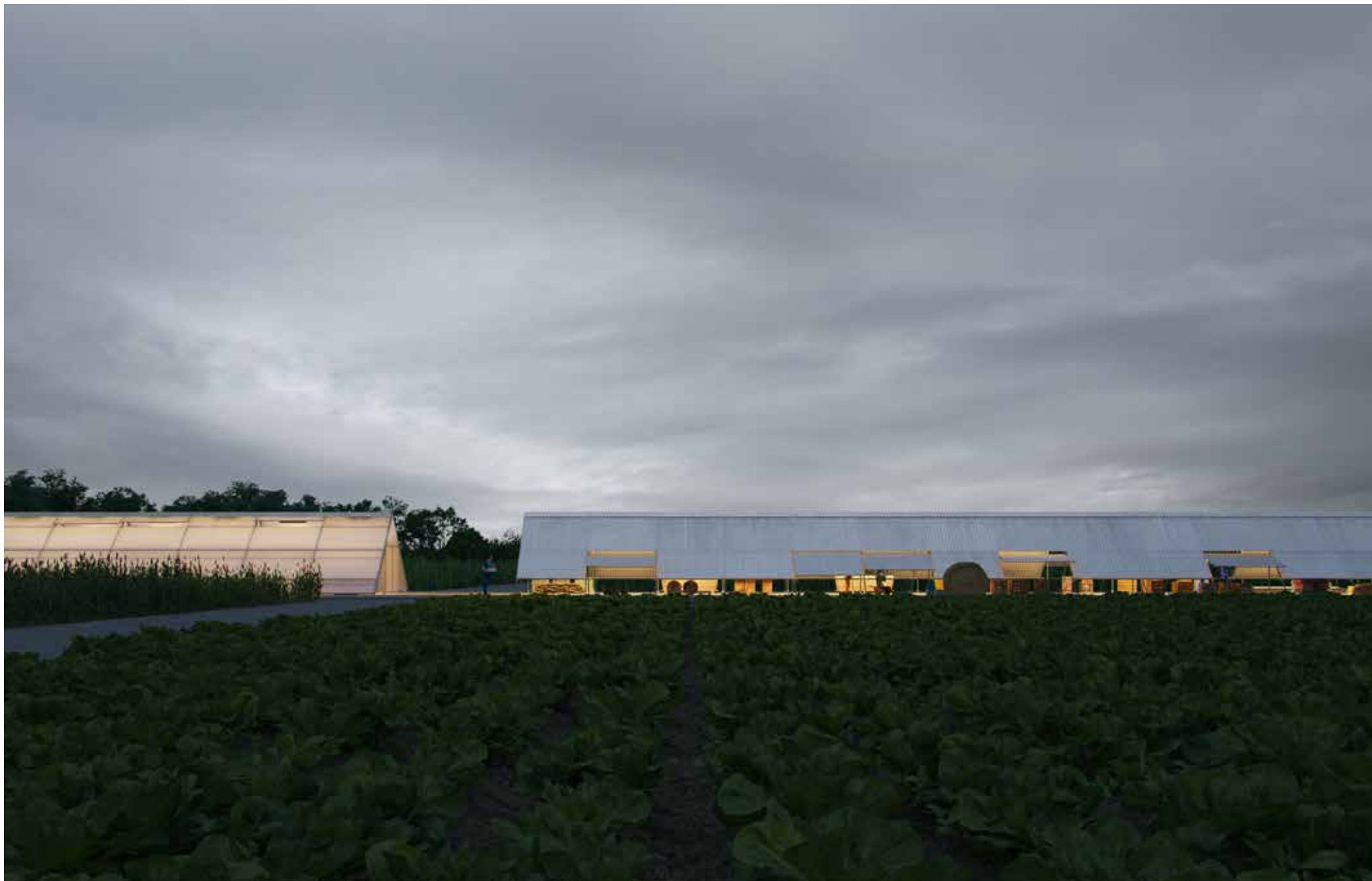
L'asse agricolo. filoferro architetti, arch. Stefano Lacala, Agreenoa, il polo di eccellenza nella formazione e ricerca , 2022, Villacidro. © slimstudio
