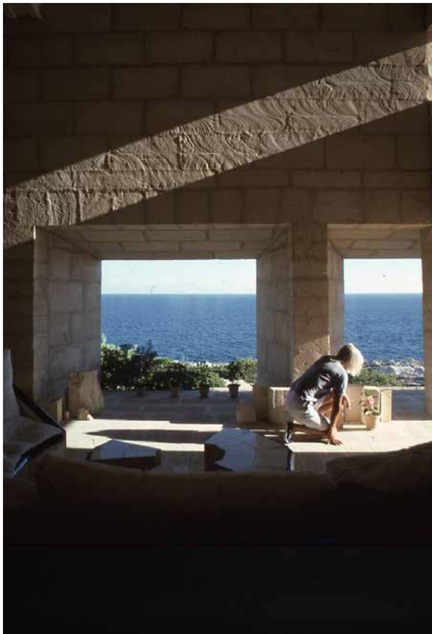
Il doppio volume del soggiorno in una foto di archivio. La feritoia bagna con un raggio di luce la muratura grezza facendo emergere i segni circolari della segatura dei conci. Il telaio a madonna delle grandi finestre è invisibile dall'esterno e il paesaggio irrompe nell'interno. Jørn Utzon, Can Lis , 1971. © Utzon Archives / Aalborg University & Utzon Center
