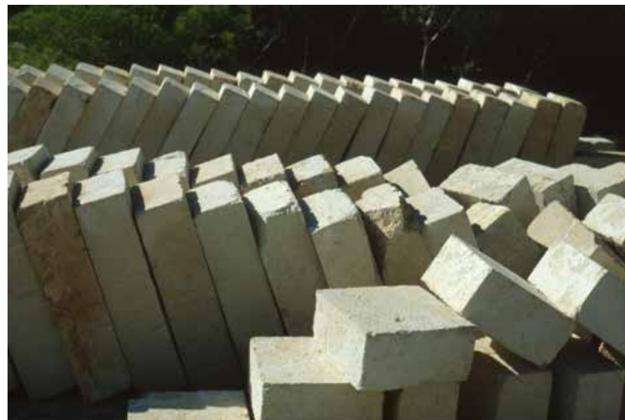
Lo stoccaggio dei blocchi di pietra arenaria con cui sono state realizzate le murature portanti. © Utzon Archives / Aalborg University & Utzon Center
